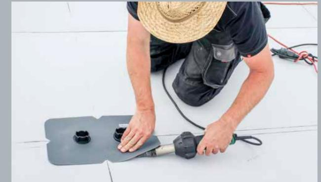
Nach dem Einmessen werden die Grundfüße mittels Manschette auf dem Dach verschweißt.
