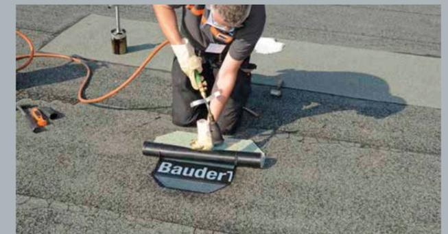
Zuletzt wird die geöffnete Stelle fachmännisch abgedichtet und ist nach der Beendigung des Dachchecks wieder sicher verschlossen.
