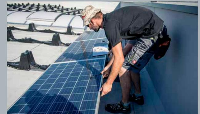
Im letzten Schritt werden die Module mit einer innovativen Klemmtechnik auf den Hauptstrukturen befestigt und bis zum Wechselrichter verkabelt.
