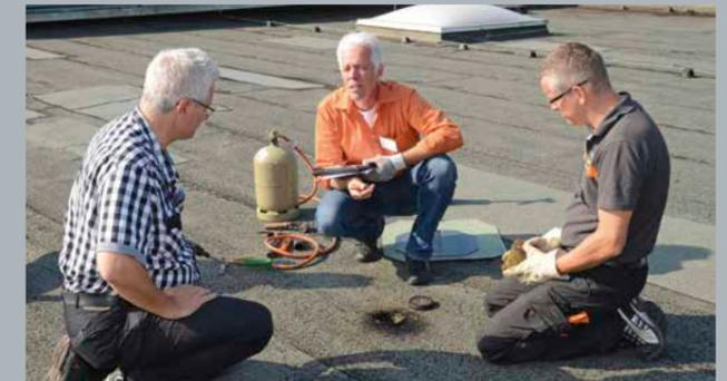
Der Dachzustand (Wärmedämmung trocken, feucht, ggf. stehendes Wasser, Dicke der Wärmedämmung, usw.) wird festgehalten und dient ggf. als Basis für einen Sanierungsvorschlag.
